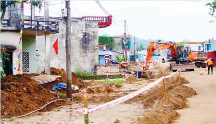
Các nhà thầu đang tích cực thi công trên phần mặt bằng được bàn giao
