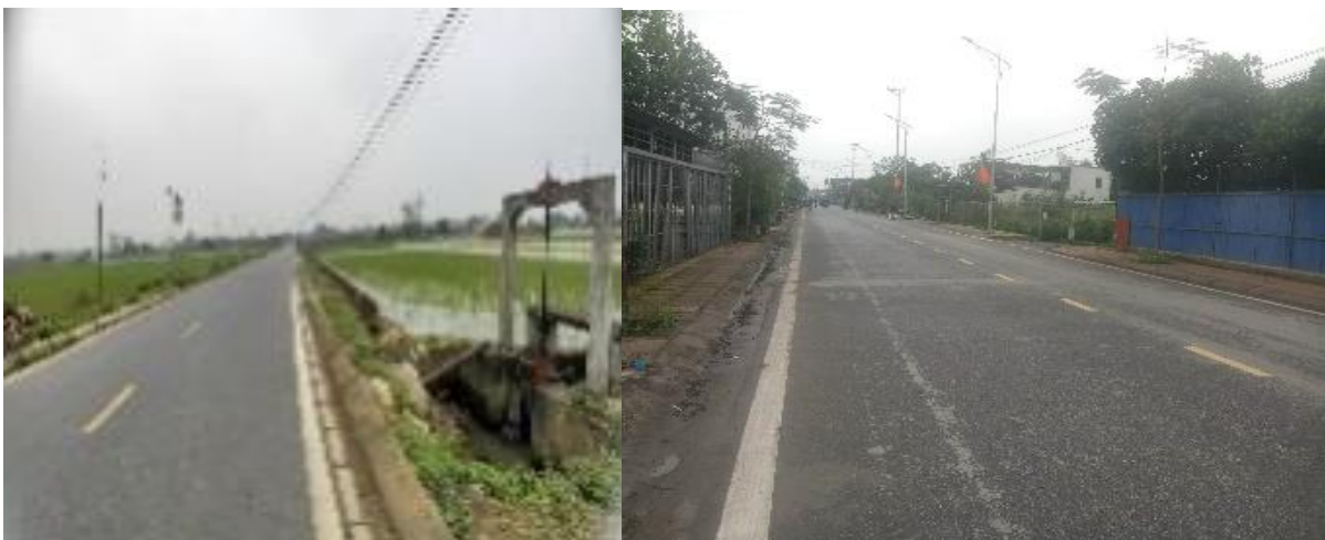
Tuyến đường liên thôn giáp dự án
