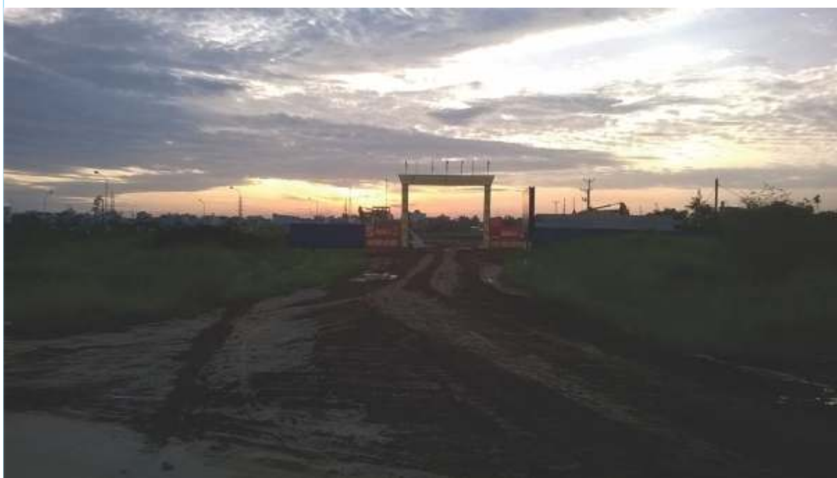
Hợp phần đường nối 2 cầu Đồng Khê và cầu Niệm 2 đi qua quận Kiến An.
