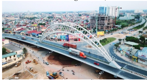
Cầu vượt giữa đường Nguyễn Văn Linh và Hồ Sen - cầu Rào 2
