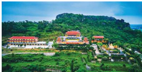
Chùa Long Hoa vừa hoàn thành phục dựng giai đoạn 1.
