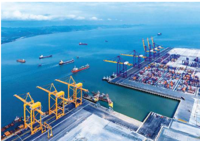
Cụm cảng cửa ngõ container quốc tế nước sâu Lạch Huyện
