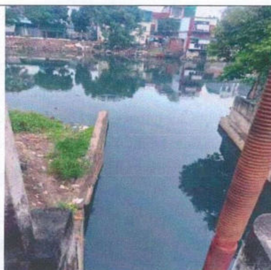
Sông Sắt tại trạm bơm Bình Lâu (bơm nước thải)
