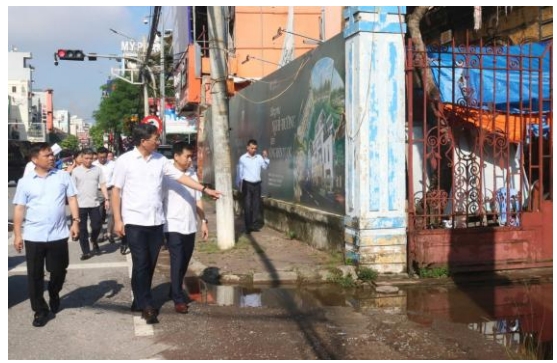
Lãnh đạo thành phố và phường đi kiểm tra tiến độ thực hiện dự án
