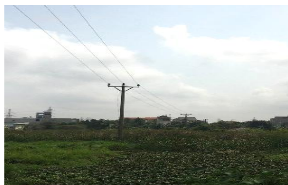
Đường dây 35/22kV
