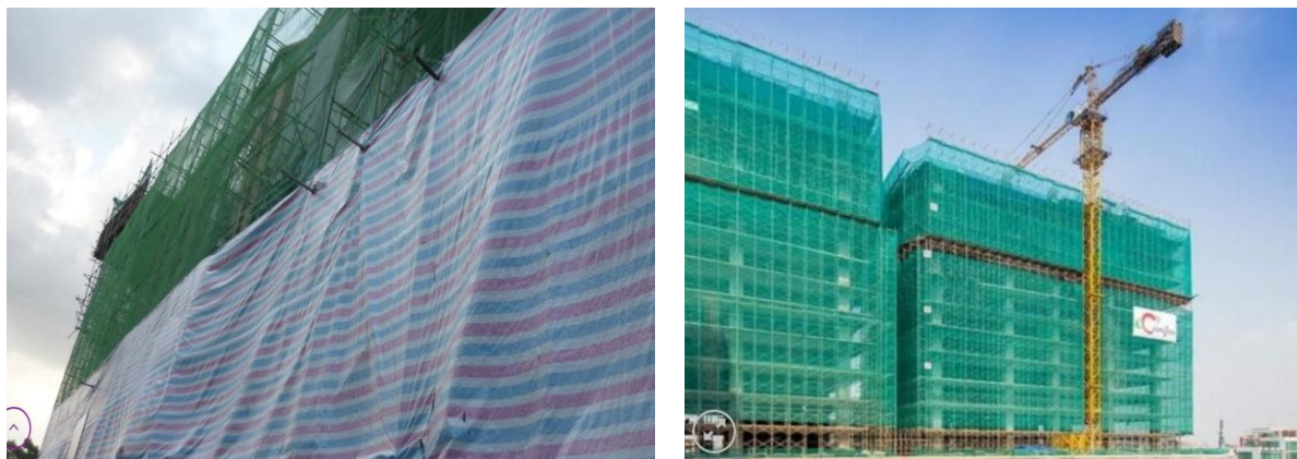
Hình 3.4. Lưới bao che công trình
