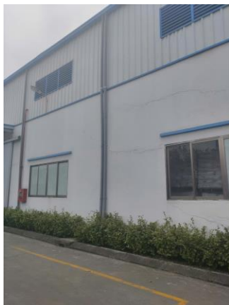
Hình ảnh hệ thống thu gom và thoát nước mưa
