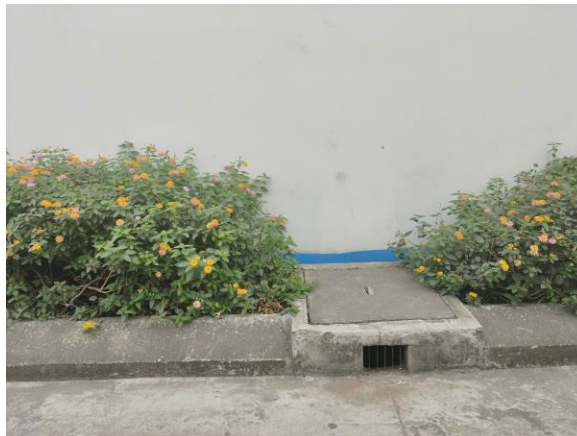
Hình ảnh hệ thống thu gom và thoát nước mưa
