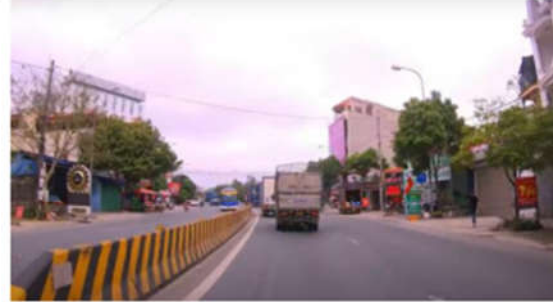
QL10 đoạn qua thị trấn Vĩnh Bảo khu vực cuối dự án
