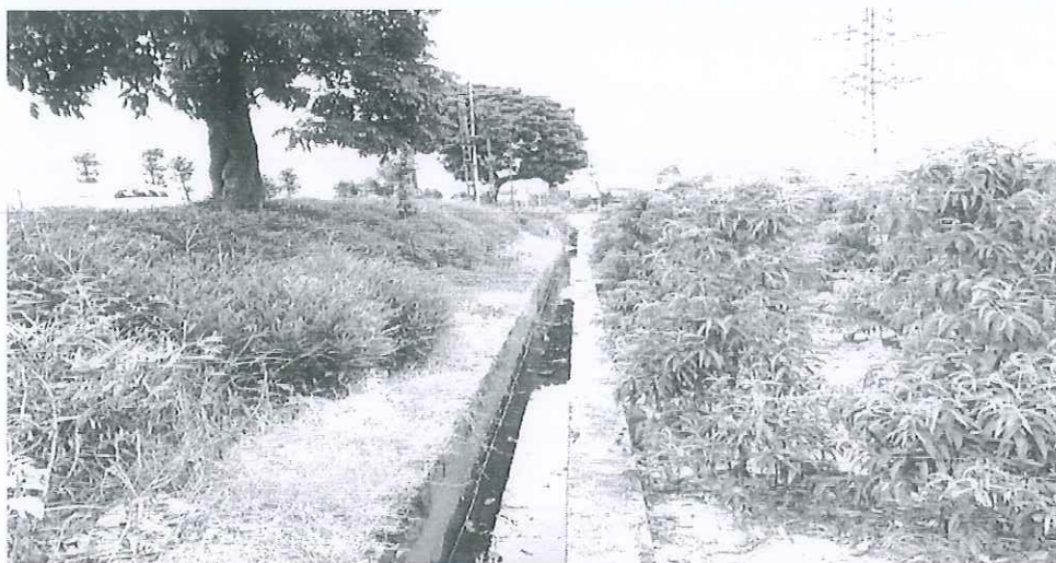
Hình ảnh một số kênh, mương thuộc phạm vi dự án
