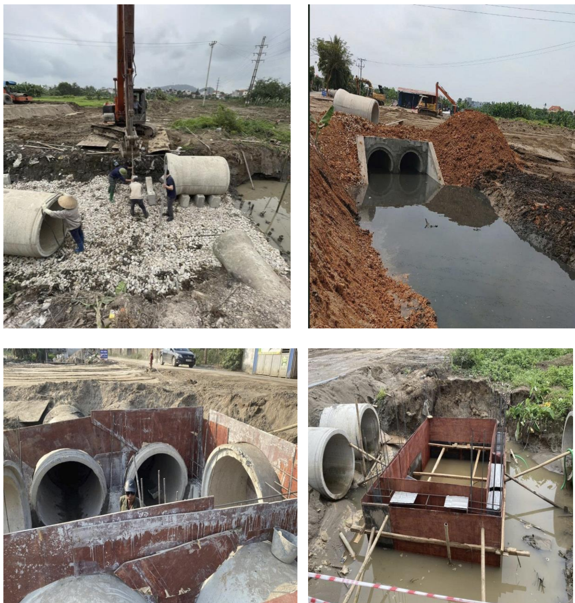
Hình 1.5. Hình ảnh thi công tuyến cống hoàn trả
