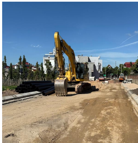
Tuyến đường đang thi công
