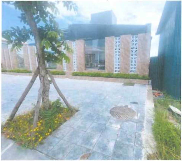
Hố ga thoát nước mưa của tại phía Tây dự án
