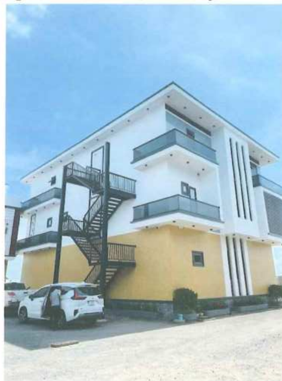
Nhà điều hành
