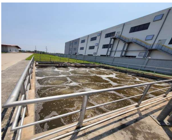
Hình ảnh bể sục khí
