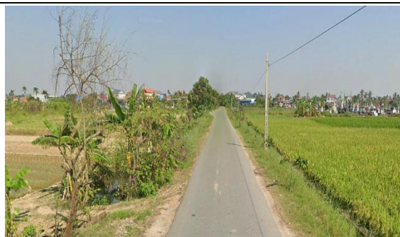
(Vị trí tuyến giao đường thôn Nghĩa Xuyên, Kim Thành)
