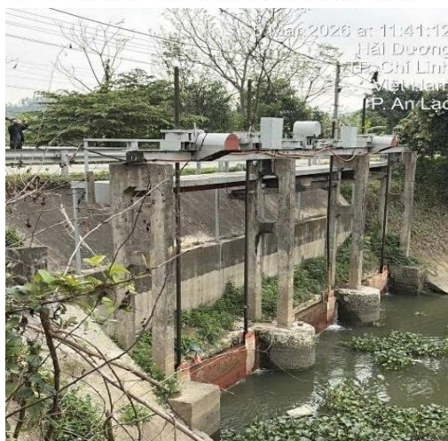
Điểm cuối kênh K14+160 - Cổng tiêu tự chảy trạm bơm An Bài mới được đầu tư
