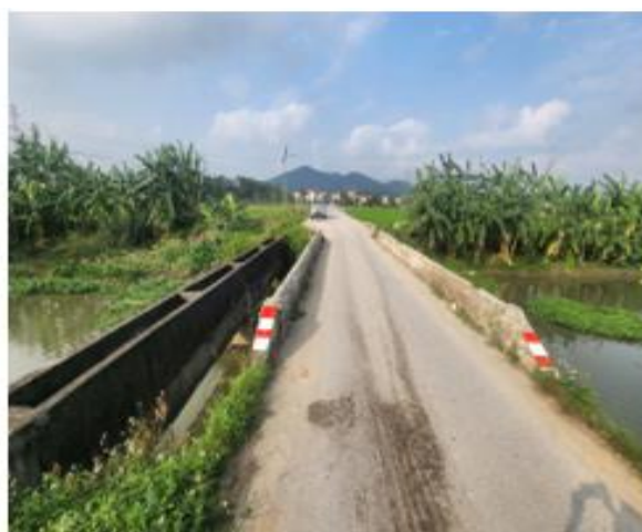
Cầu qua kênh tại K3+795 xây dựng đã lâu, chiều rộng thông thủy không phù hợp với hạ tầng kết nối cần được cải tạo (đã được đầu tư dự án khác)
