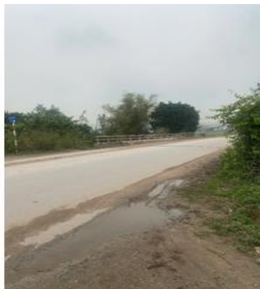
Cầu qua kênh tại K7+960 khẩu độ đảm bảo bảo và kết cấu còn tốt
