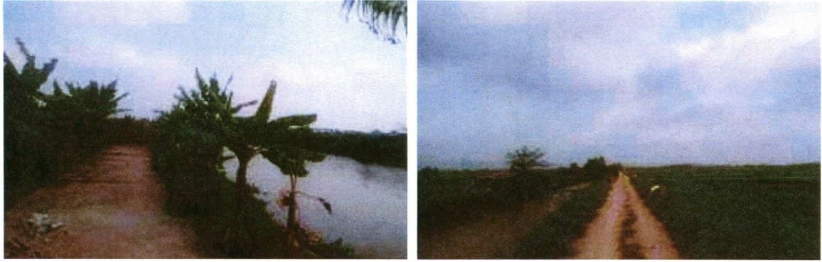
Hình 6. Hình ảnh hiện trạng kênh mương khu vực dự án
