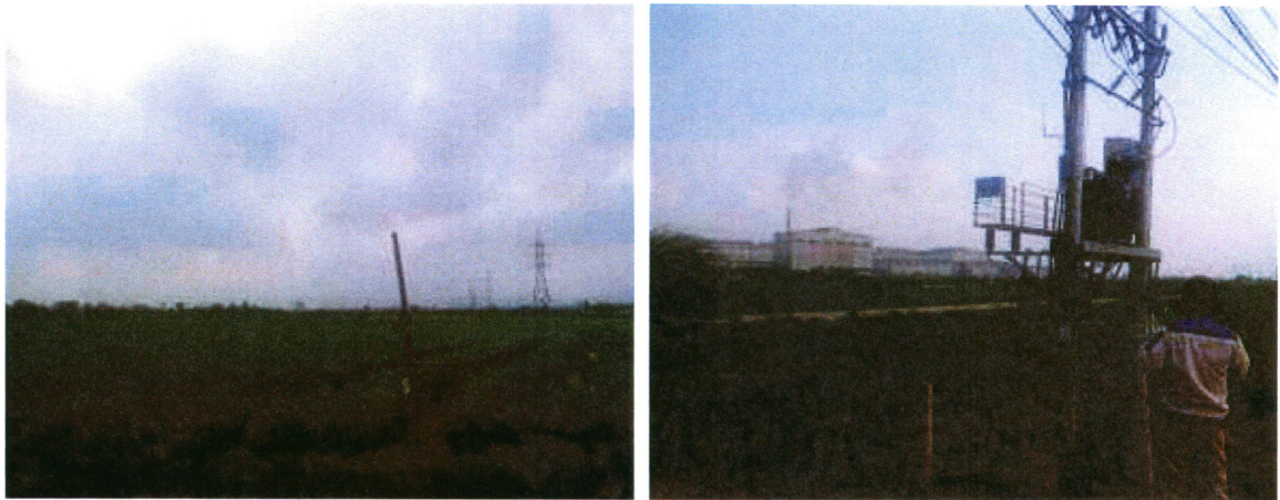
Hình 5. Hiện trạng tuyến đường điện 110kV và trạm biến áp 400kVA-35/0,4kV trong khu vực thực hiện dự án
