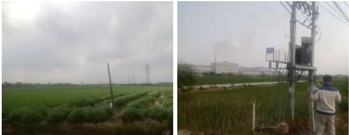
Hình 1.5. Hiện trạng tuyến đường điện 110kV và trạm biến áp 400kVA-35/0,4kV trong khu vực thực hiện dự án
