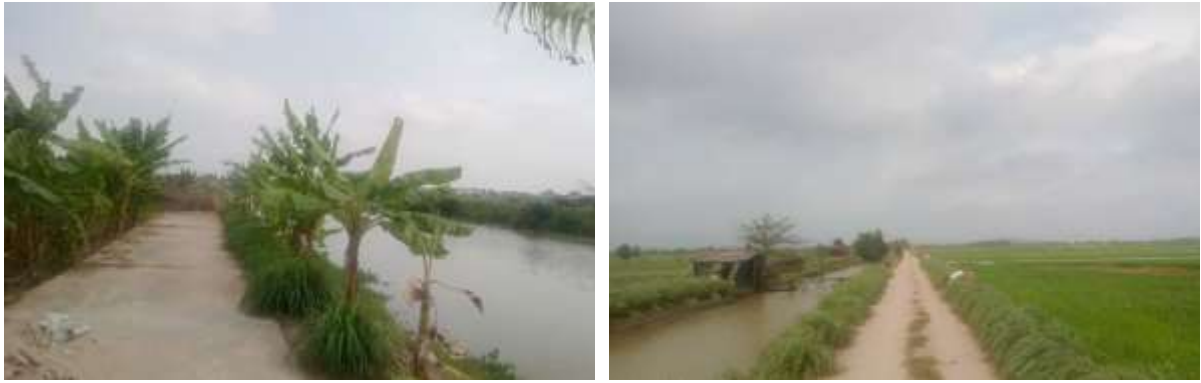
Hình 1.6. Hình ảnh hiện trạng kênh mương khu vực dự án
