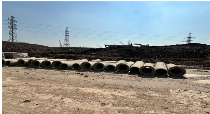
Hiện trạng khu đất nhà xưởng C2
