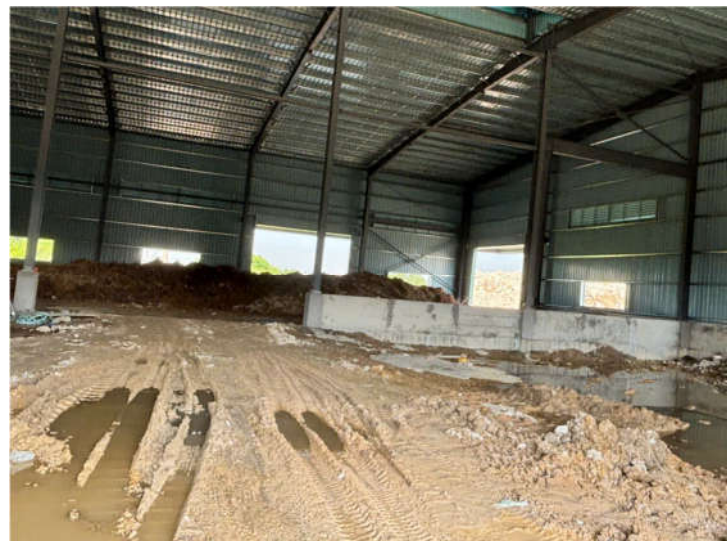
Hiện trạng khu nhà xưởng C1
