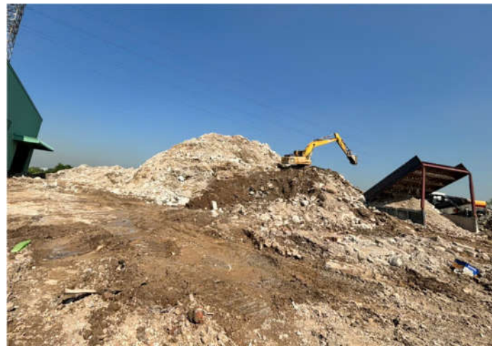
Hiện trạng khu phụ trợ B2
