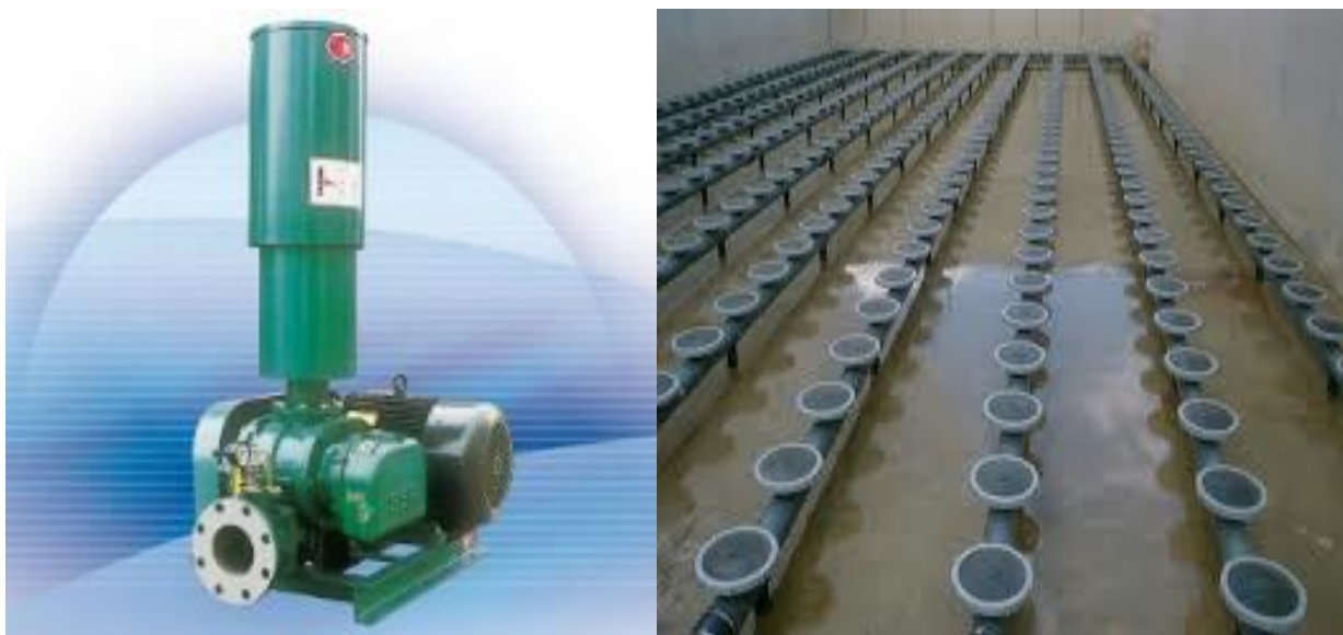
Hình 3.6. Hình ảnh máy thổi khí và hệ thống phân phối khí (đĩa phân phối khí)
