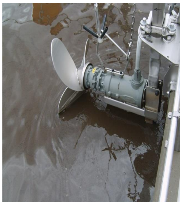
Hình 3.4. Hình ảnh máy khuấy chìm trong bể thiếu khí
