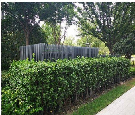
Trạm biến áp
