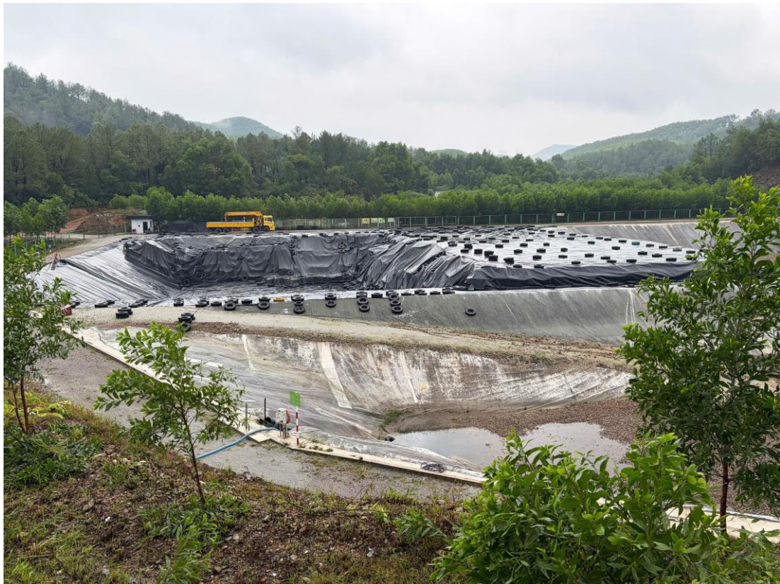
Hình 4.20: Hình ảnh ô chôn lấp tro bay (nhà máy điện rác Huế)
