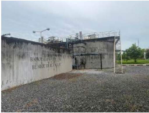
Bể nước rửa ngược, bể chứa bùn
