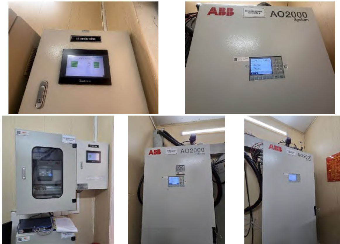
Hình 3.18. Hình ảnh hệ thống quan trắc khí thải tự động, liên tục
