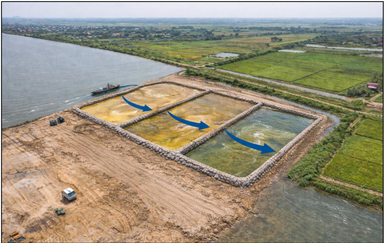
Hình 4.5. Hình ảnh minh họa các ô san lấp cát trong phạm vi dự án
