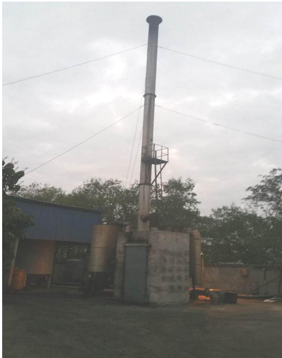
Hệ thống xử lý tuần hoàn nước làm mát và dung dịch hấp thụ để xử lý khí thải lò đốt chất thải nguy hại
