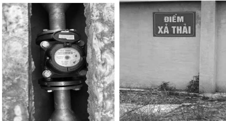
Hình 3.12. Đồng hồ đo lưu lượng và điểm xả nước thải
