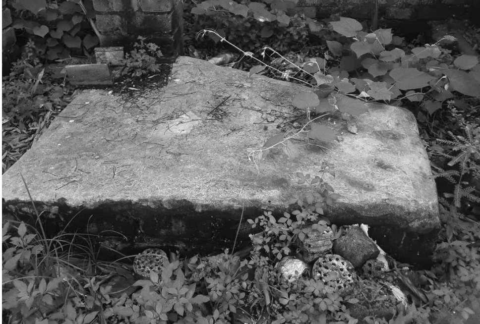
Hình 3.8. Bể tách mỡ nước thải khu bếp ăn
