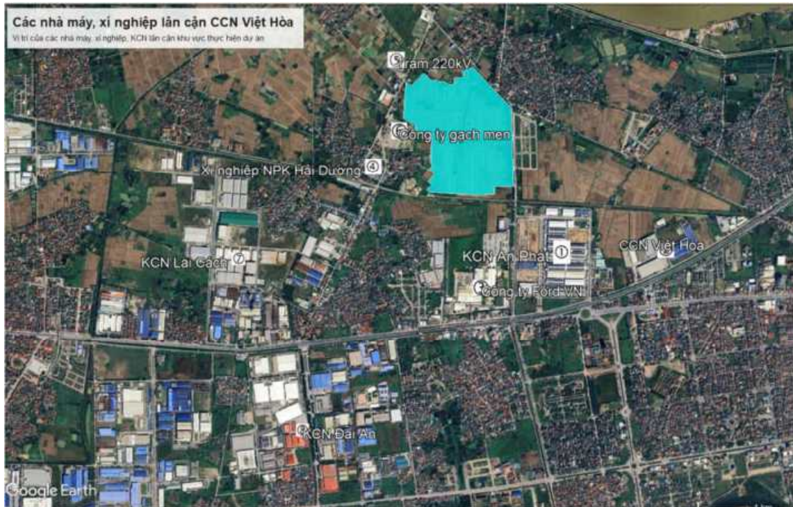
Hình 1. 11. Các nhà máy, xí nghiệp, khu công nghiệp lân cận dự án
