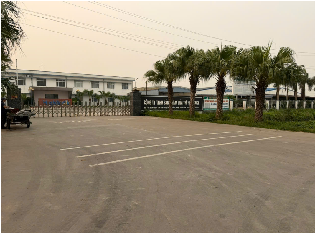
Hình 1.2: Một số hình ảnh hiện trạng khu vực thực hiện dự án:
