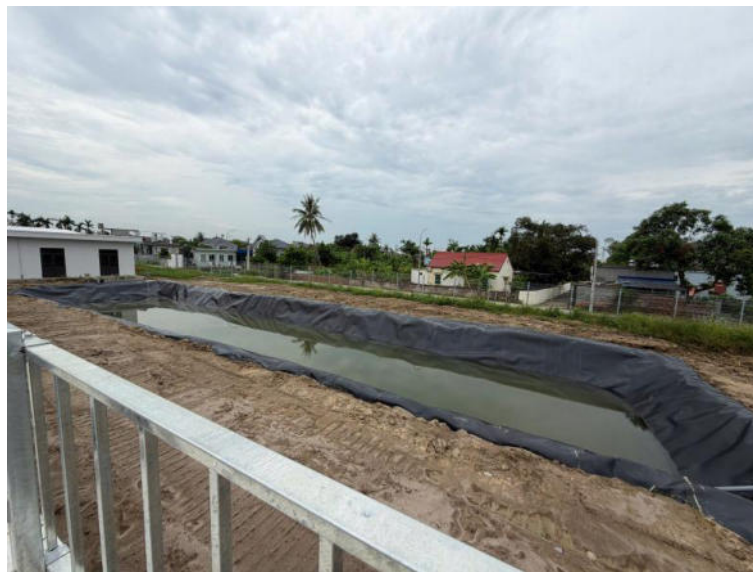
Hình 3.10. Hồ sự cố của dự án
