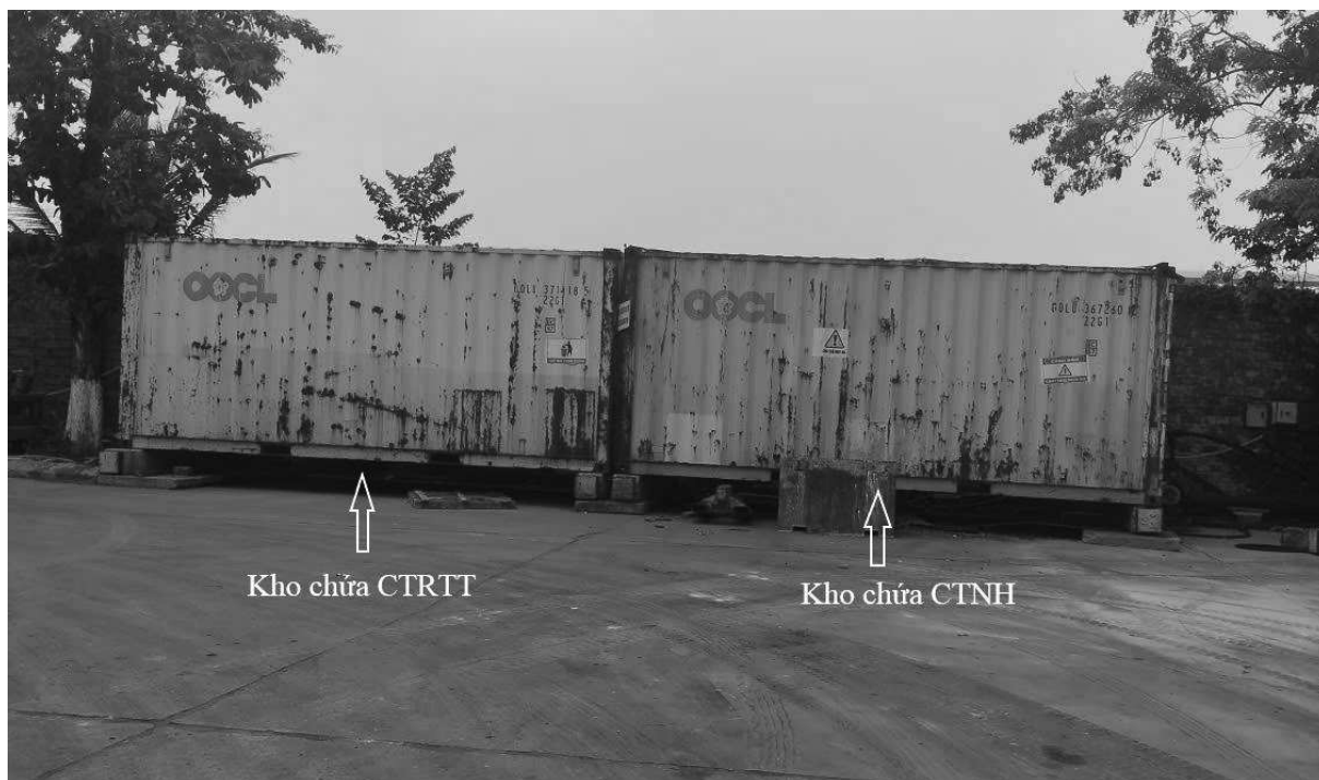
Hình 3.27. Kho chứa chất thải rắn công nghiệp thông thường
