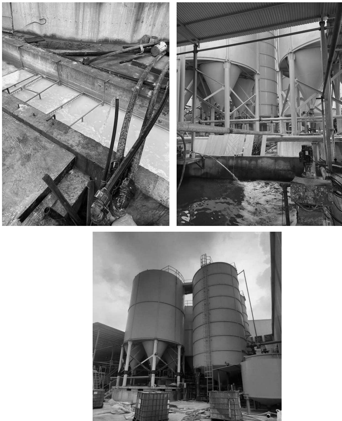
Hình 3.10. Hình ảnh máng thu nước tuần hoàn và bể nước thải sản xuất tuần hoàn
