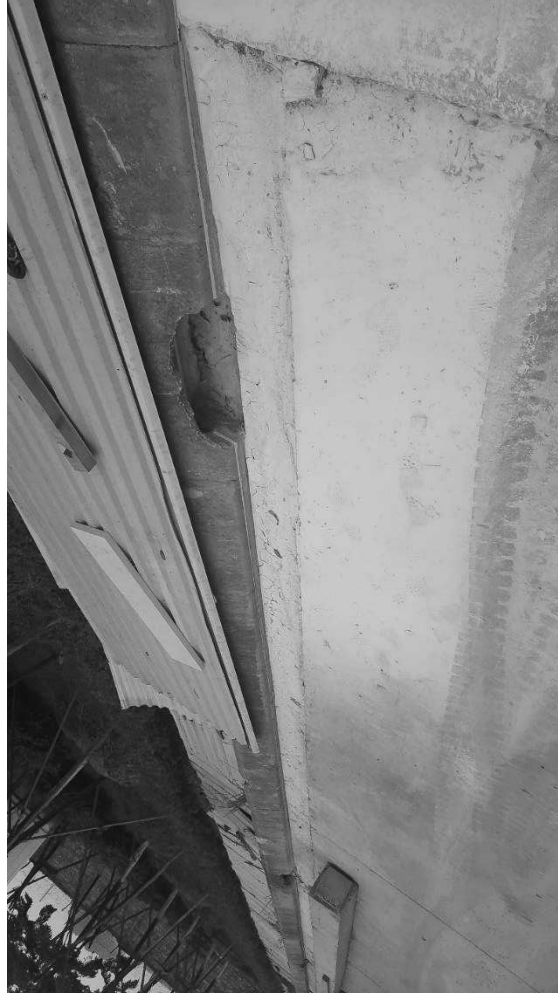
Hình 3.2. Hệ thống thu gom, thoát nước mưa
