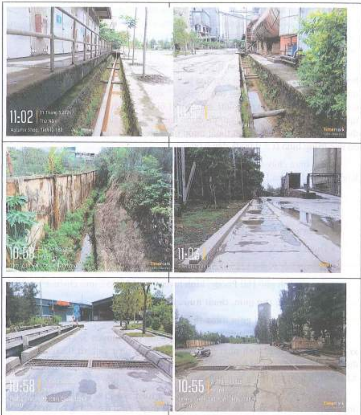
Hình 3.1. Hình ảnh hệ thống thoát nước mưa của Nhà Máy dây chuyền 3, khu vực nghiên cứu xi măng Z3
