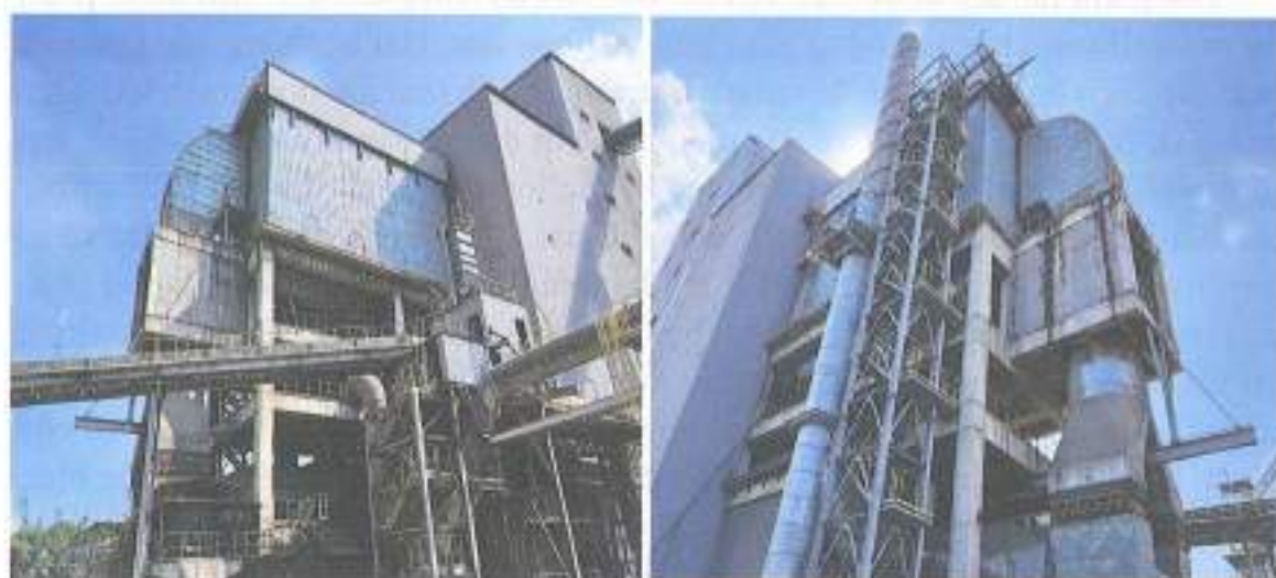
Hình 3.10. Ảnh thực tế hệ thống lọc bụi túi công suất lớn 1651BF01 tại nghiền xi măng Z3
