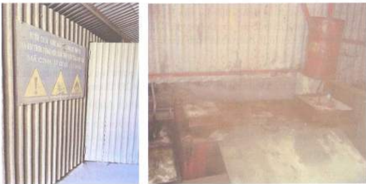
Hình 3.19. Hình ảnh công trình xử lý dầu thải
