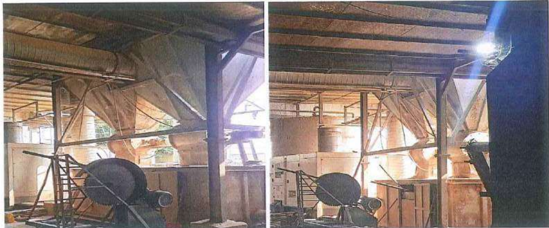
Hình 3.7. Hệ thống lọc bụi đã được lắp đặt tại Công ty
