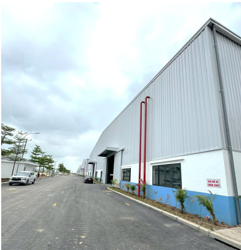
Hình 1.2. Khối 5 nhà xưởng
