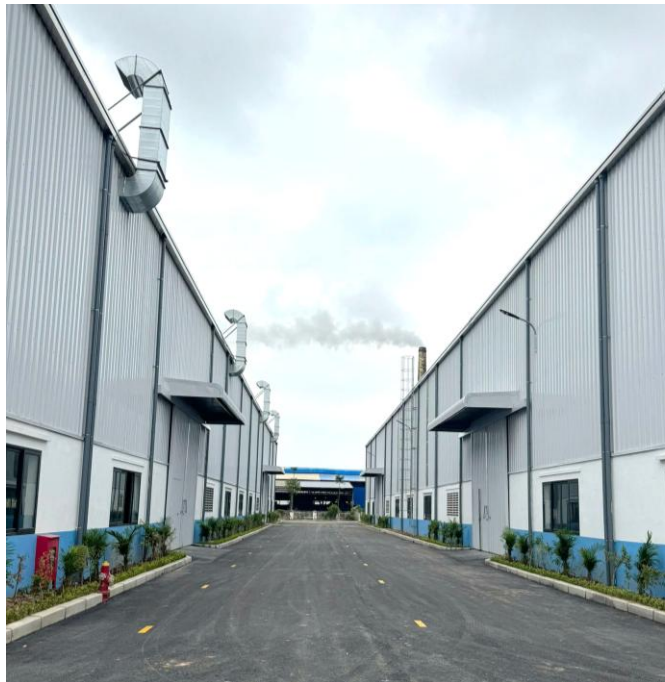
Hệ thống ống thu nước mưa từ mái
