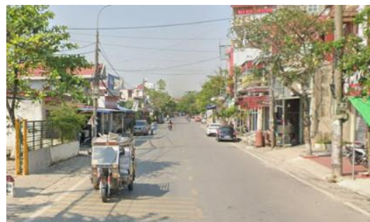
Đường 208 (khu vực dân cư đông đúc)
