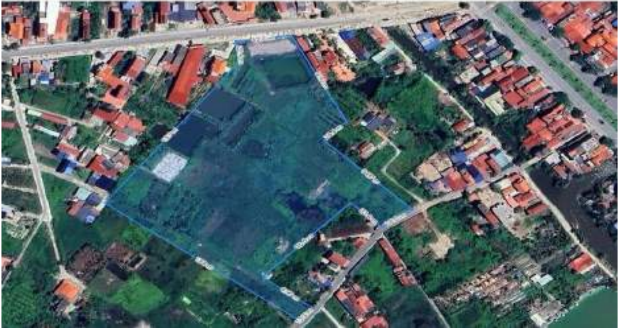
Hình 1.7. Hiện trạng khu vực thực hiện dự án khu TĐC Dương Kinh
