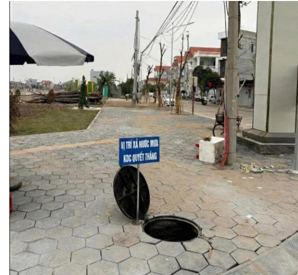
Cửa xả 2 phía Tây Bắc dự án
