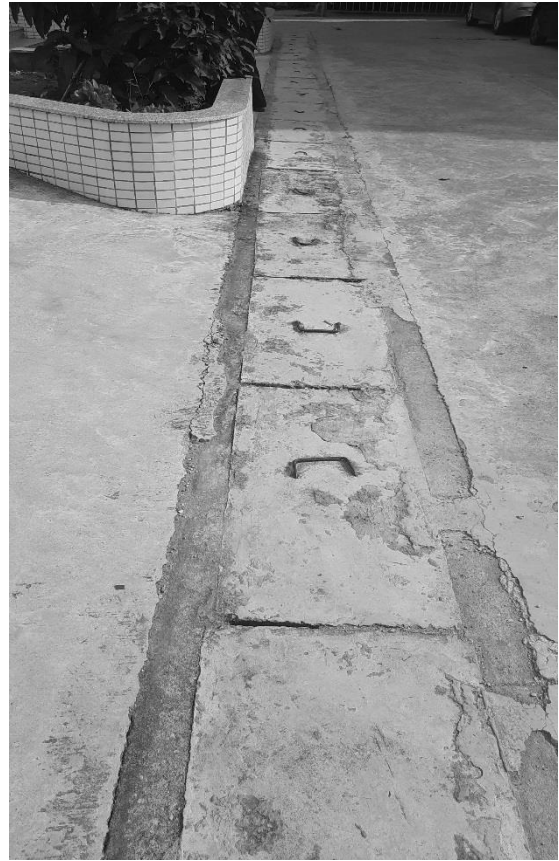
Hình 3.2. Hệ thống thu gom, thoát nước mưa hiện trạng
