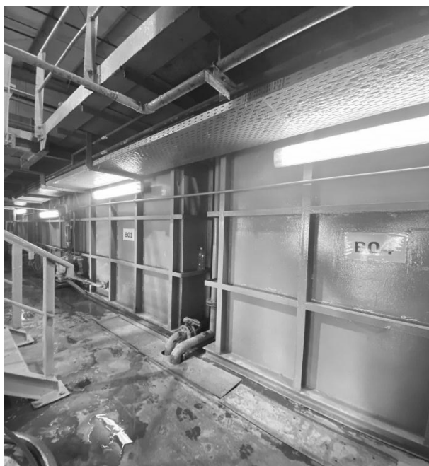
Bể thu gom
