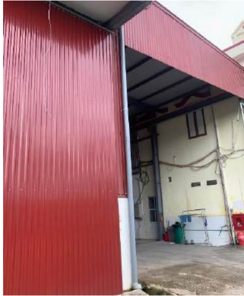
Ống đứng thoát nước mặt PVC Ø150
