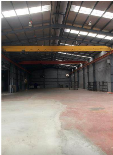
Nhà xưởng B
