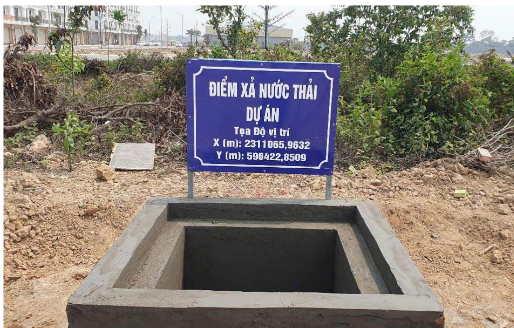
Hình 3. 5. Hình ảnh điểm xả nước thải tại dự án
