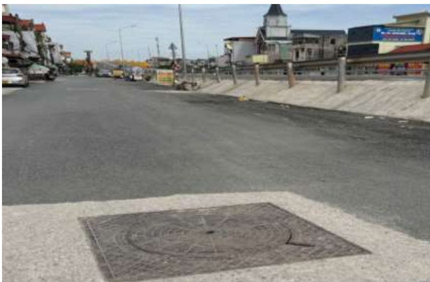
Hình 1.14. Hình ảnh hố ga đầu nối thoát nước thải của dự án
