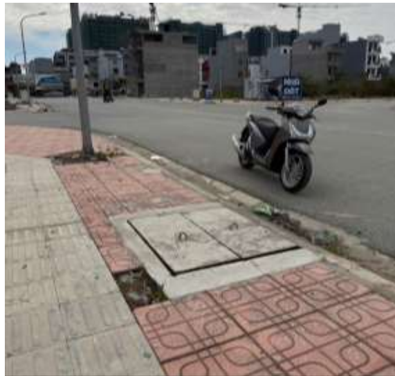
Điểm đầu nối thoát nước mưa số 3
