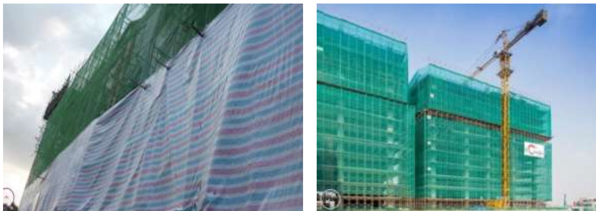
Hình 4.1. Lưới bao che công trình
