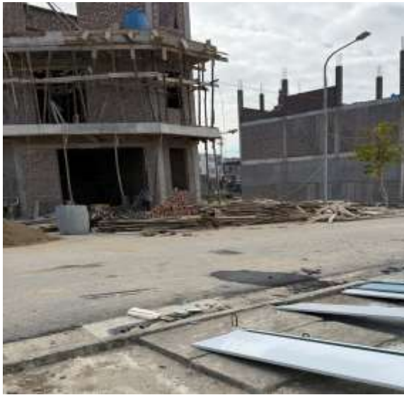
Điểm đầu nối thoát nước mưa số 1
