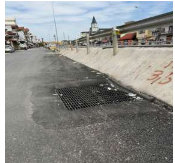
Điểm đầu nối thoát nước mưa số 4
