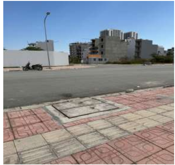
Điểm đầu nối thoát nước mưa số 2
