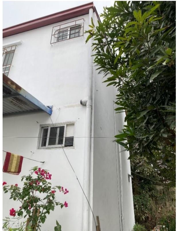
Thu nước mưa mái
