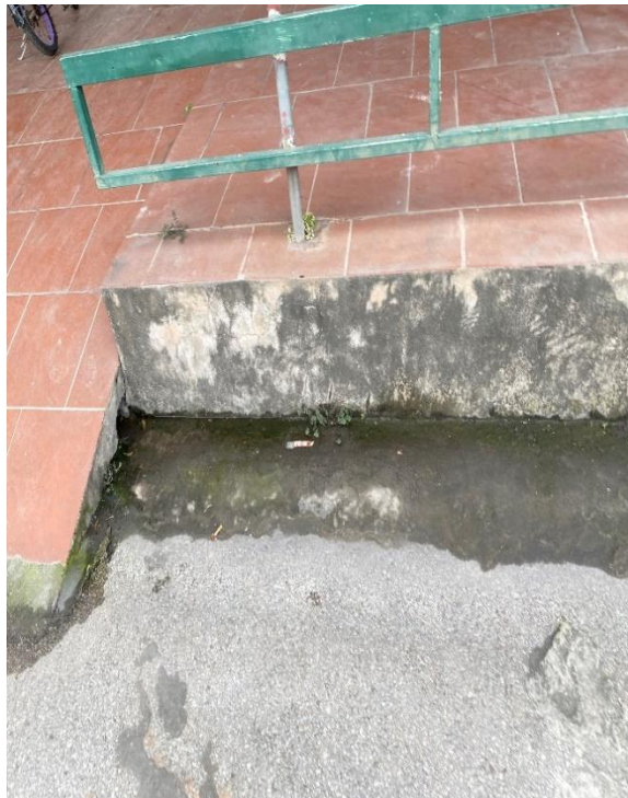
Cửa và rãnh thu nước mưa
