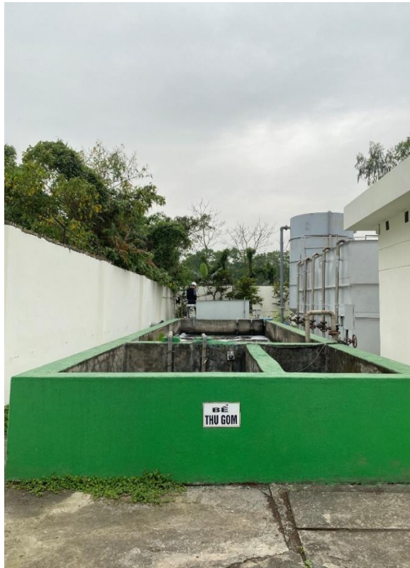
Bể thu gom
