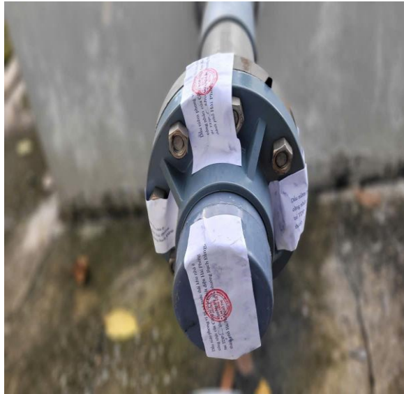
Hình ảnh niêm phong hòng xả nước thải của cơ sở
