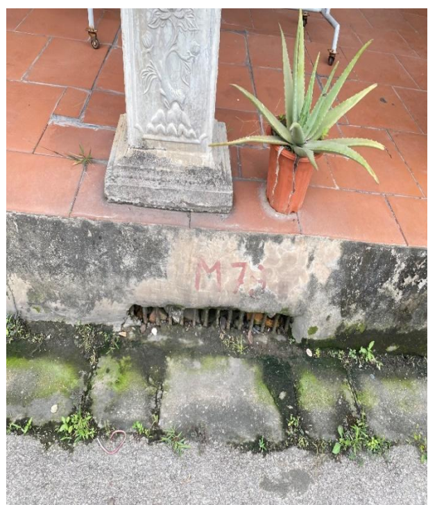
Cửa và rãnh thu nước mưa
