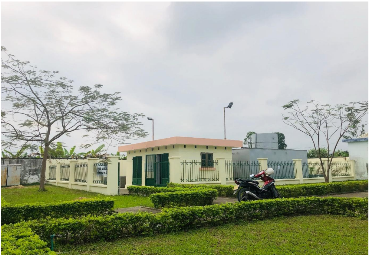
Hình 3.11. Hình ảnh trạm xử lý nước thải công suất 200m 3 /ngày.đêm
