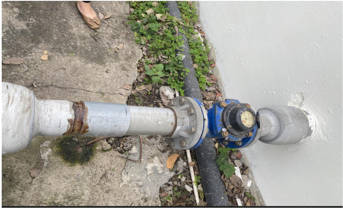
Đồng hồ đo nước thải xả ra ngoài môi trường của cơ sở
