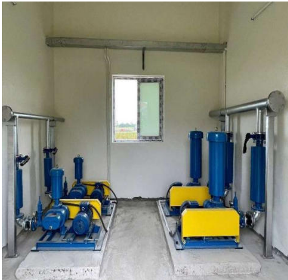
Máy bơm, máy thổi khí
