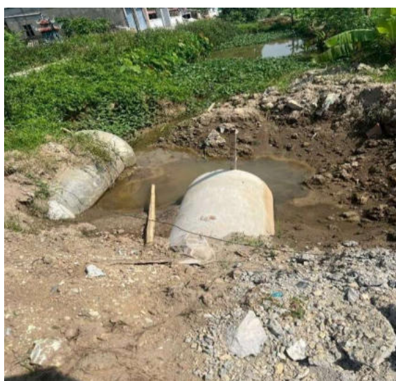
Hình 3. 4. Cửa xả nước mưa của dự án
