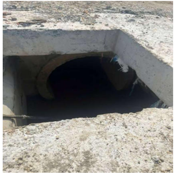
Hình 3. 6. Cửa xả nước thải của dự án ra nguồn tiếp nhận
